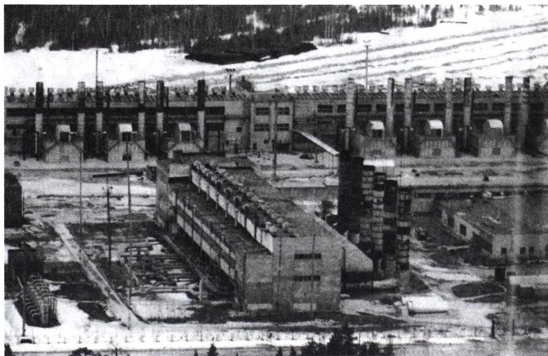
Строительство промышленной зоны города Нижневартовска
