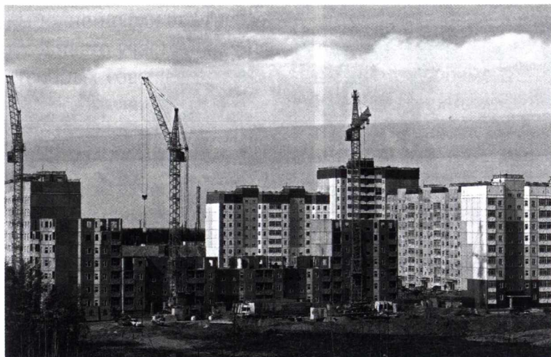
Строители преумножают традиции первых трестов и объединения «Нижневартовскжилстрой»
