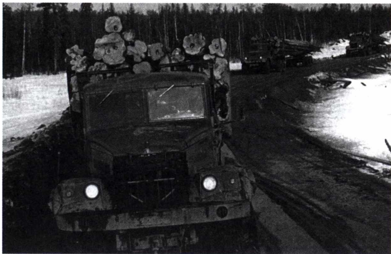
Строительство первой автомобильной дороги, соединяющей Мегион с Нижневартовском
