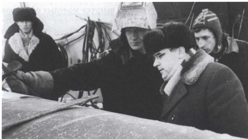
Первый секретарь ЦК ВЛКСМ Б.С. Пастухов на трассе строительства нефтепровода Самотлор – Альметьевск
