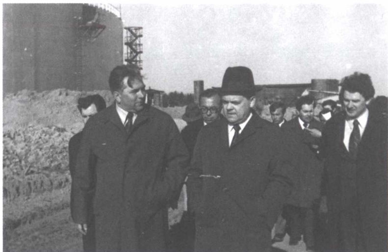
На строительстве Варьеганского ЦТП. Нижневартровский район, 1974 г.
