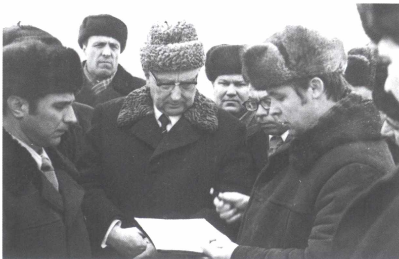
В. Д. Шашин рассматривает проект строительства на Самотлорском месторождении. Нижневартовск, 1975 г.
