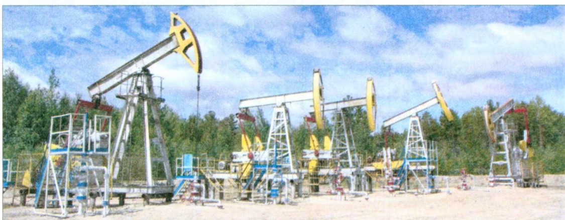
На сегодняшний день электродвигателями с вентильным приводом оборудованы 200 скважин. Внедрение техники нового поколения продолжается
