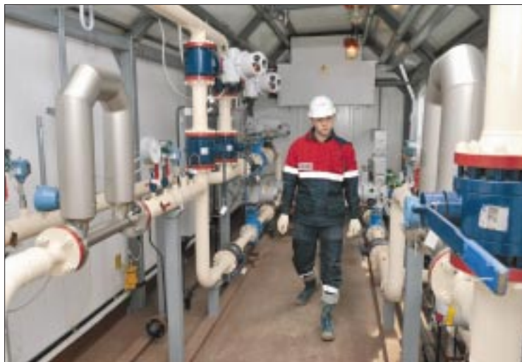
На ДНС углеводородное сырье готовится до товарной кондиции и здесь же сдается в коммерческую трубопроводную сеть. Оборудование по контролю качества и количества товарной нефти работает без сбоев
