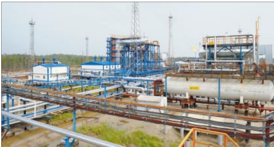
На ДНС углеводородное сырье готовится до товарной кондиции и здесь же сдается в коммерческую трубопроводную сеть. Оборудование по контролю качества и количества товарной нефти работает без сбоев
