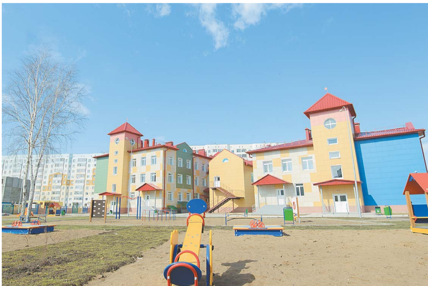
Меньше двух лет длилось строительство д/с «Совенок».
