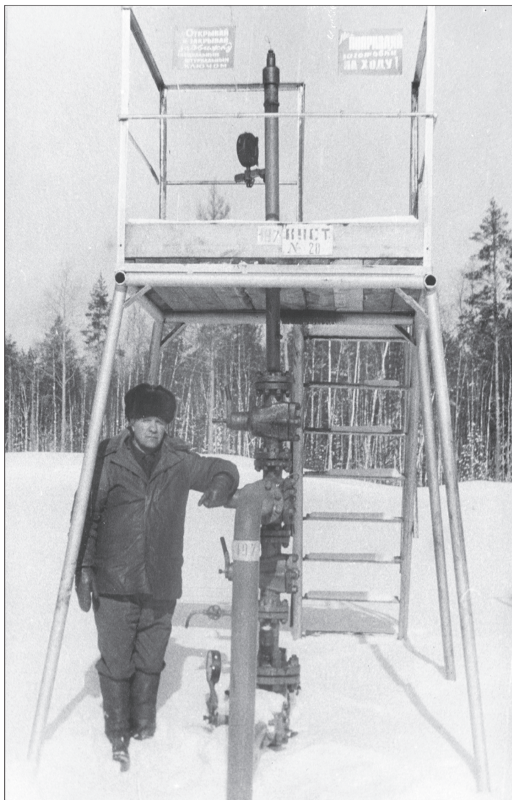
На счету оператора подземного ремонта скважин Якова Мартына сотни объектов «Мегионнефтегаза», введенных в эксплуатацию
